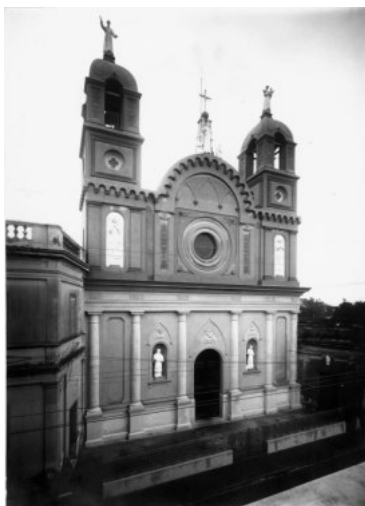
Fig. 2 Antiguo templo de San Francisco Soriano levantado por los primeros franciscanos llegados en 1855. Se derrumbó en 1951
